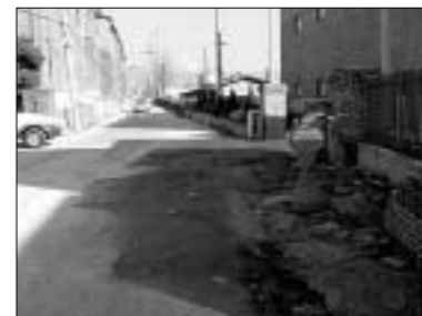
포천이 훼손된 차랑소통에 지장을 주었던 신북면 신평리 신평염색공단 진입로(사진 위쪽)가 아스콘 덧씌우기 공사를 통해 말끔하게 단장됐다. (사진 아래쪽)
