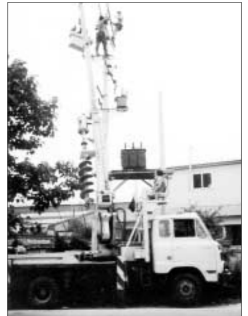
공장확장으로 인한 부하설비 증가로 특별 고압 자가용 수선설비 증설 공사 현장
