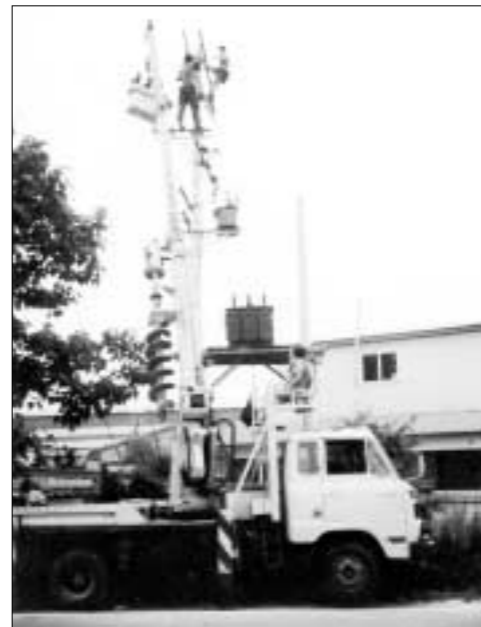
공장확장으로 인한 부하설비 증가로 특별 고압 지가용 수전설비 증설 공사 현장
