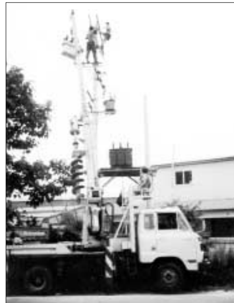
공장확장으로 인한 부하설비 증가로 특별 고압 자기용 수전설비 증설 공사 현장
