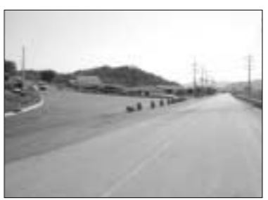
10월 중 준공될 예정인 진상리~왕림리간 도로 확·포장공사 구간.
