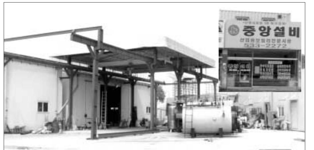
중앙설비는 수요자의 욕구를 만족시키며 유지공장, 제지공장, 섬유공장, 벽돌공장, 아파트와 시설재배 농가용 온수보일러 등을 필요로 하는 업체에 제작 공급하며 업계 선두주자로 자리매김하고 있다.(포천시 신북면 기지리 109-5에 위치한 중앙설비사(사진))
