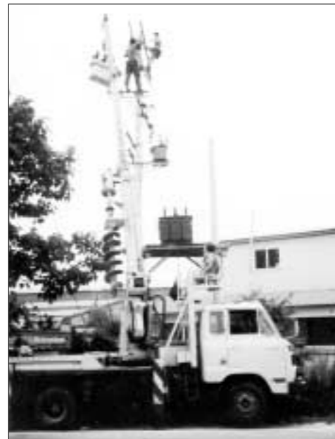
공장확장으로 인한 부하설비 증가로 특별고압 자가용 수전설비 증설 공사 현장
