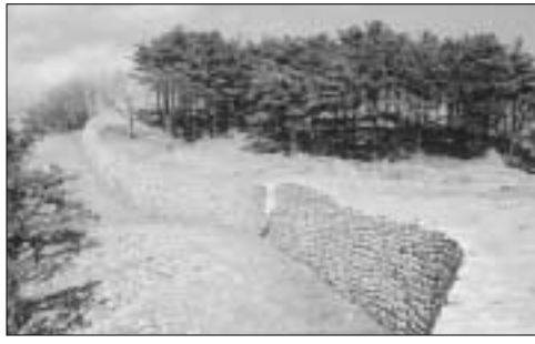
국가지정사적 제403호로 지정된 군내면 구읍리 산5-1번지 반월성지 전경.
