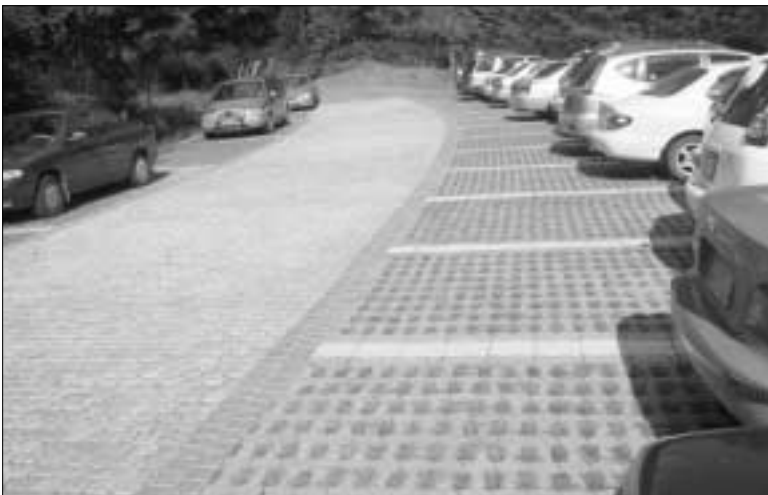
친환경 공영주차장이 설치된 티저어 사례.
