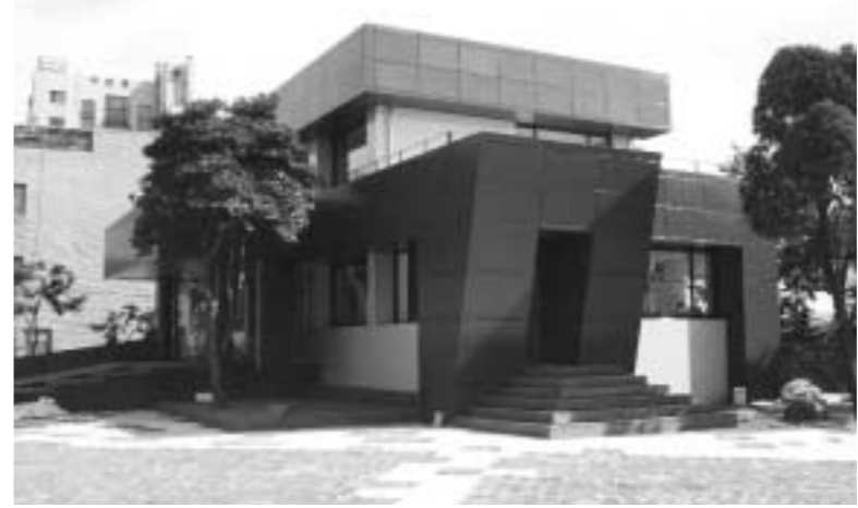
포천시내 풍물로 방치되었던 구 등기소 건물이 새롭게 리모델링을 마치고 청소년 상담실과 자원봉사센터로 단장한다.
